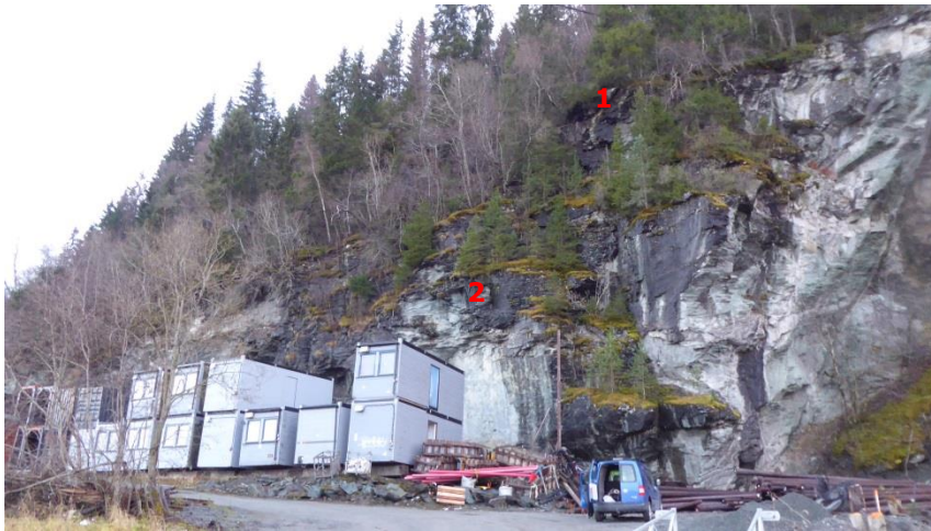
Bilde 2: Nedre del av brudvegg. Bergmasse ved «1» og «2» framstår som avløst, og er også vist i Bilde 1.
