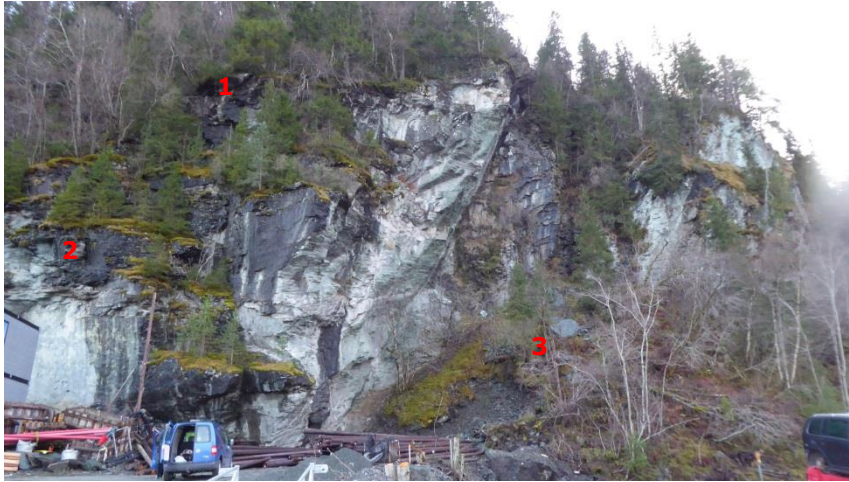
Bilde 1: Vestre del av brudvegg. Bergmasse ved «1» og «2» framstår som avløst. Se nærbilder i Bilde 3. Ved «3» er det en skredvifte av steinsprangmaterialer.
