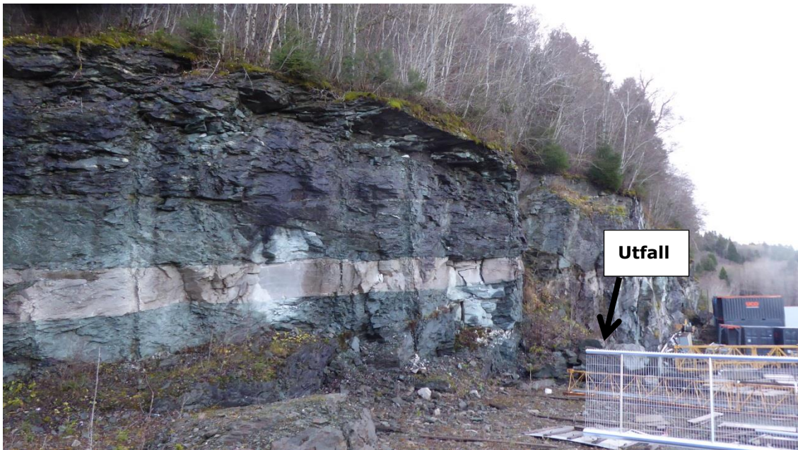
Bilde 5: Østre del av bruddveggen. Det er registrert utfall som har løsnet fra bruddveggen. Bergmassen i bruddveggen er oppsprukket, og det er observert flere partier med bergmasse som framstår som avløst i bakkant.
